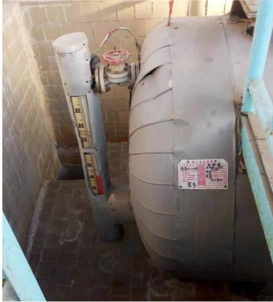
图 4.2-11 12 万吨 98%硫酸储槽
